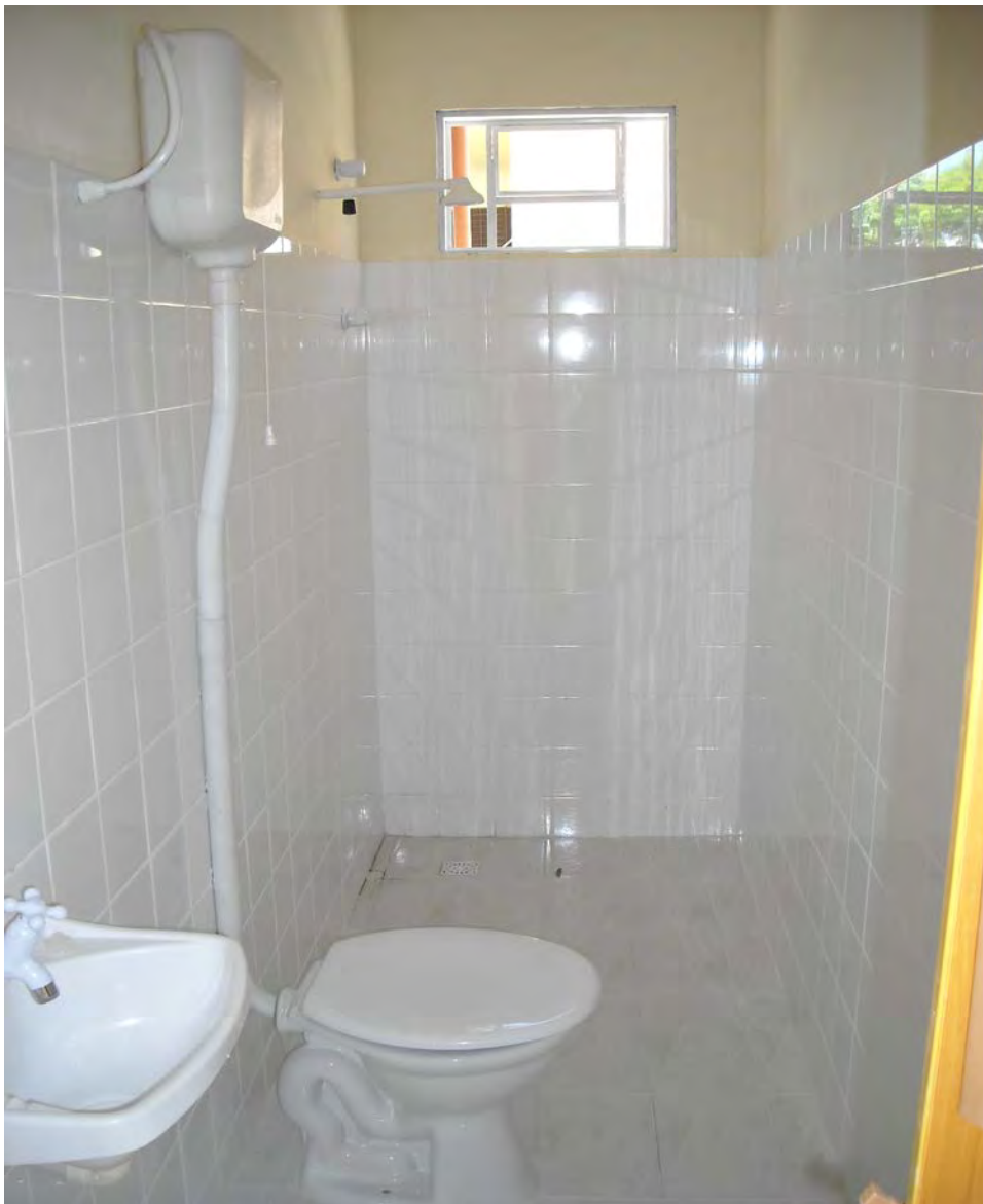
Foto 3 – Ao fundo dois registros, o de cima para as águas das chuvas e o de baixo para o sistema de abastecimento da rua. Vê a colocação dos azulejos e a qualidade do acabamento.
