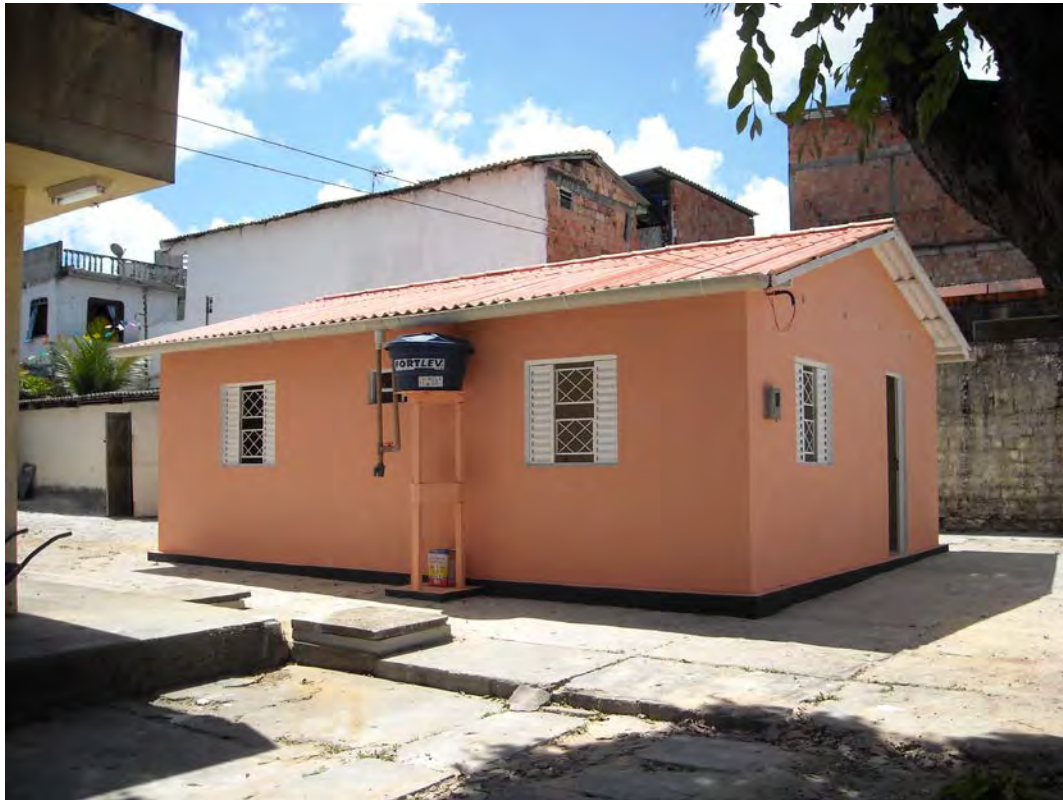
Foto 1 – Protótipo construído, na extremidade do telhado a calha para captação das águas das chuvas
