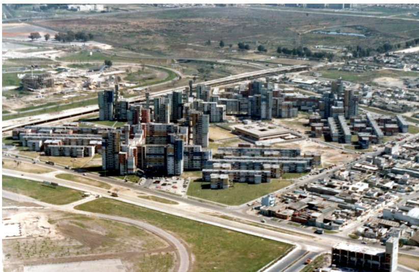
Figura 2: Conjunto Urbano Soldati, 3200 viviendas (Concurso PEVE 1972, construido con fondos FONAVI 1977-1979)
